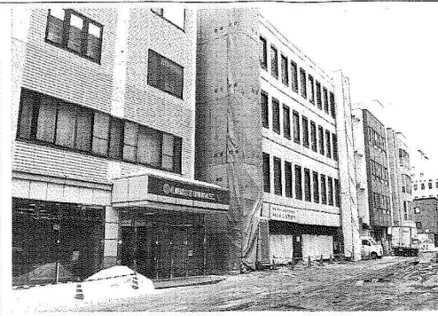
既存ビルの解体が進む社屋建設予定地
